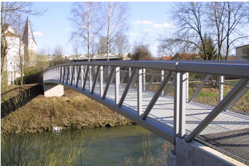
Beispiel: Stahlbrücke als Fachwerkbrücke
