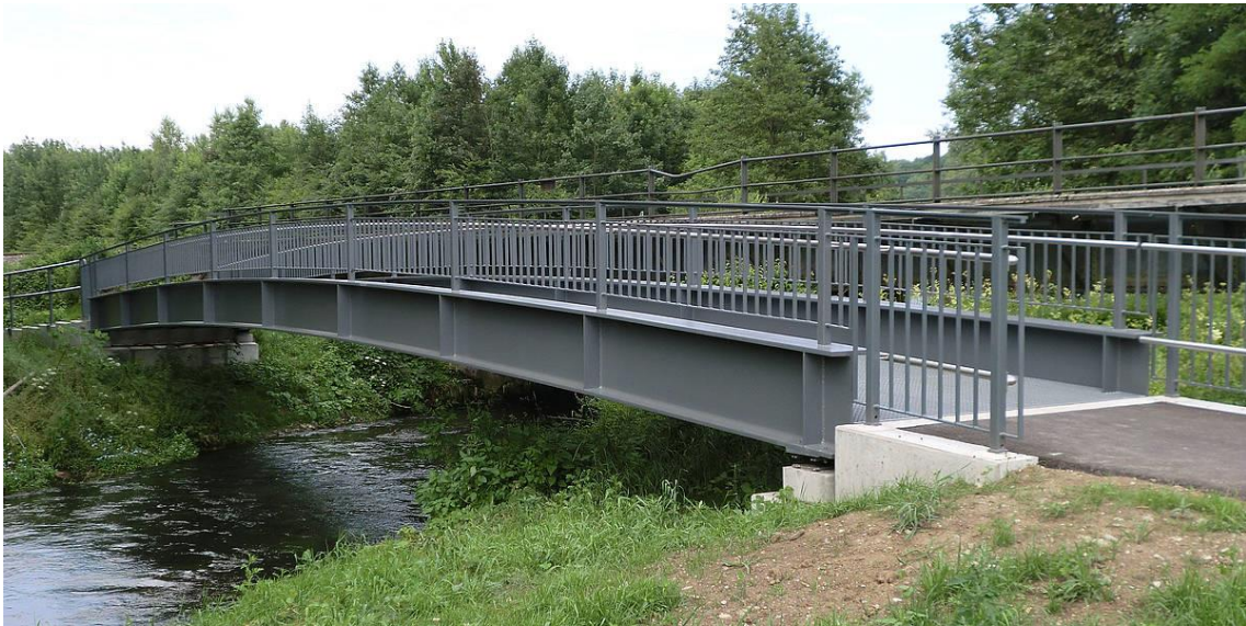
Beispiel: Stahlbrücke als Trogbrücke
