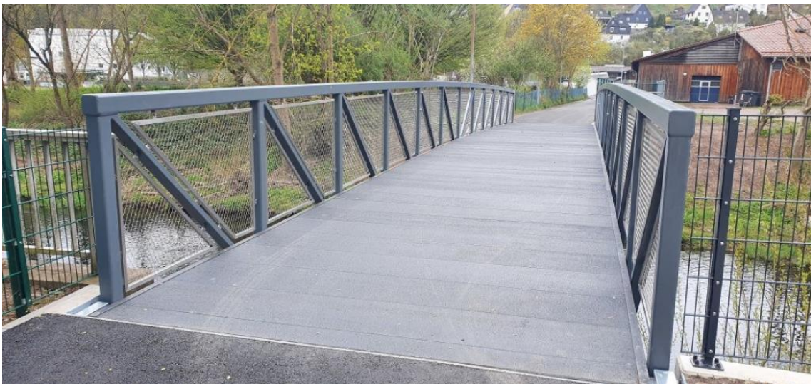
Beispiel: Stahlbrücke als Fachwerkbrücke
